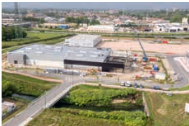
Chantier de la nouvelle carrosserie multimarque de D'Iteren à Drogenbos, en périphérie bruxelloise.
